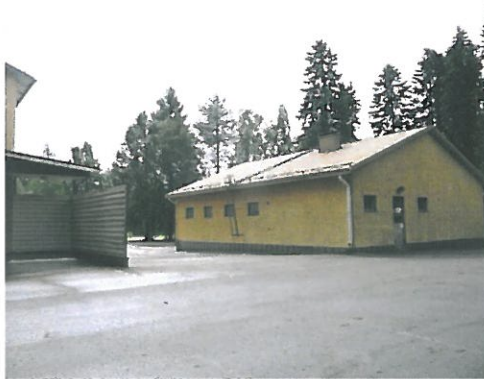
Virastotalon autotallirakennus takaa
