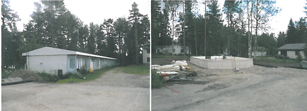
Rivitalo hotellin takana, joka on nyt purettu Uuden matkailurakennuksen perustuksia
