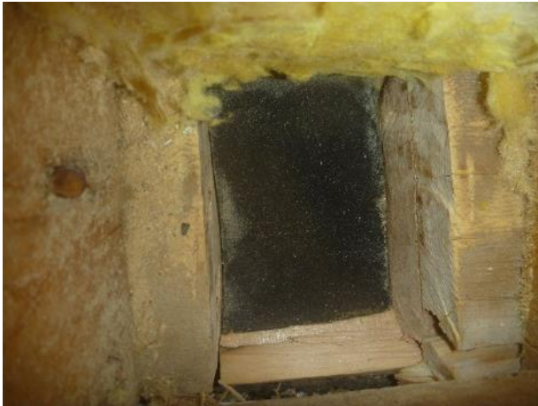
Kuva 24. RA4. Alaohjauspuun alla on bitumikermi. Näyte M5 otettiin mineraalivillasta alaohjauspuun päältä.
