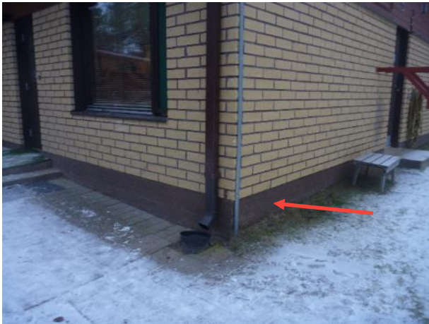
Kuva 10. Rakenneavauksen RA1 kohta ulkoa kuvattuna.
