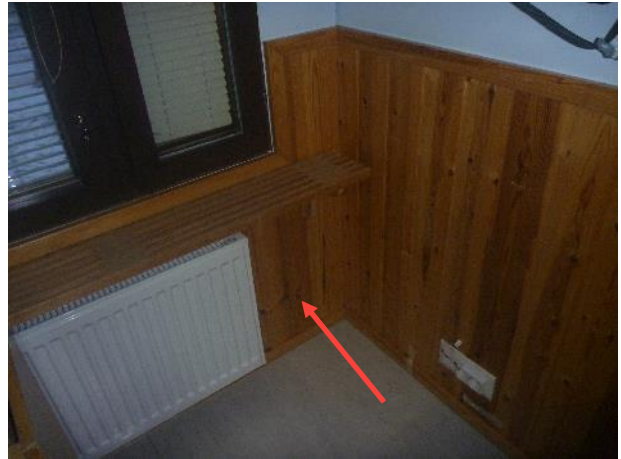
Kuva 19. RA2. Rakenneavauksen kohta sisällä.
