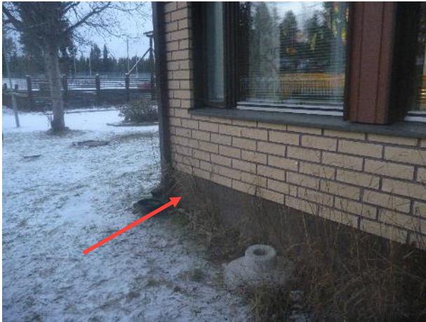
Kuva 18. Rakenneavauksen RA2 kohta ulkoa kuvattuna.
