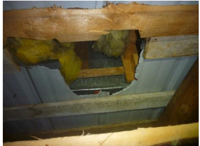
Kuva 34. Alkuperäinen ilmanvaihtohormi yläpohjatilassa. Vanhat IV-putket poistettu koneellisen ilmavaihdon myötä.
