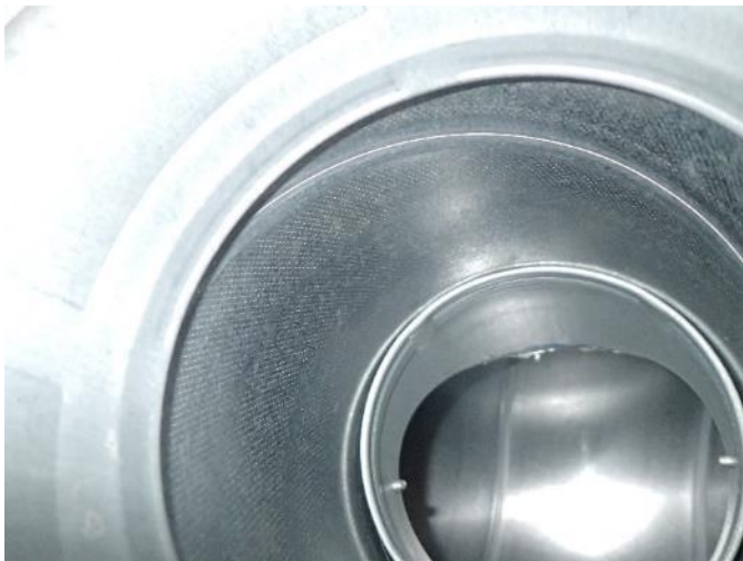
Kuva 1. Tuloilmakanava puolukan puolella. Kanavan sisäpinnalla ei ole näkyvää pölyä.
