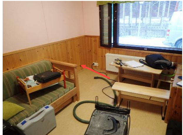
Kuva 11. RA1. Rakenneavauksen kohta sisällä.
