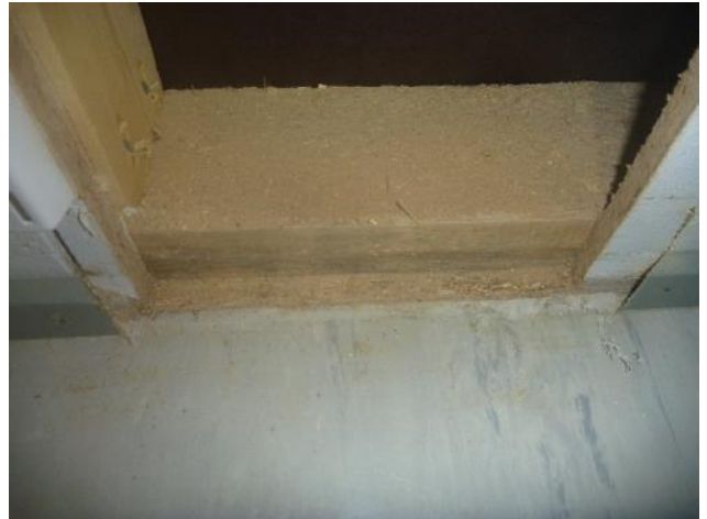
Kuva 27. RA3. Väliseinärungon alajuoksu on asennettu lattiabetonin päälle.
