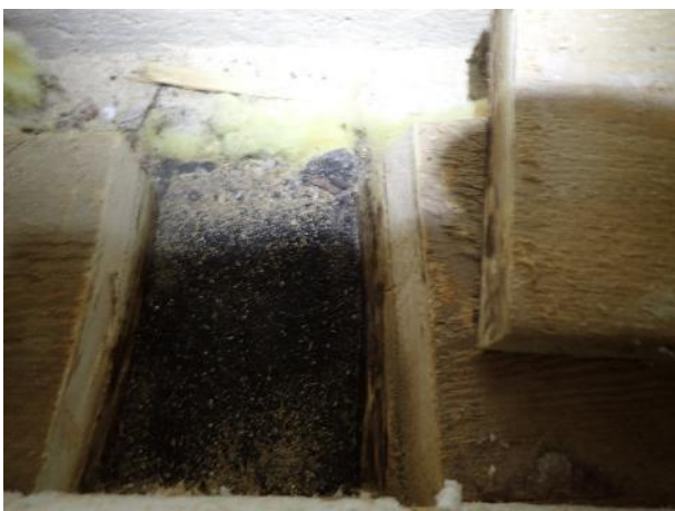
Kuva 16. RA1. Alaohjauspuun alla on bitumikermi ja mineraalivilla. Näyte M1 otettiin mineraalivillasta alaohjauspuun alta.
