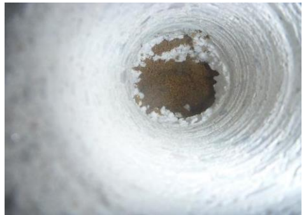
Kuva 9. RA5. Alapohjaeristeenä rakennuksen keskialueella on styroxia 50 mm.
