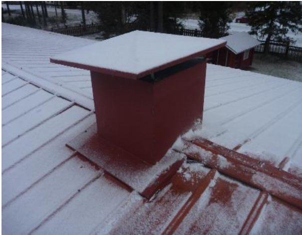
Kuva 33. Alkuperäinen ilmanvaihtohormi.
