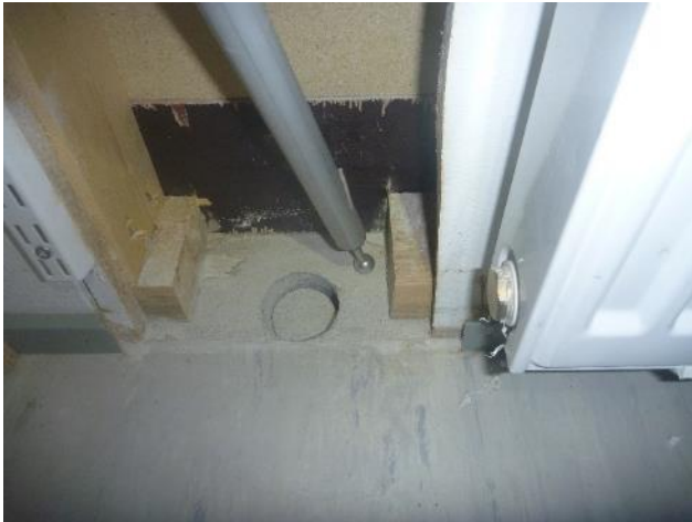
Kuva 28. RA3. Betonilaatta on yhtenäinen väliseinän alla.
