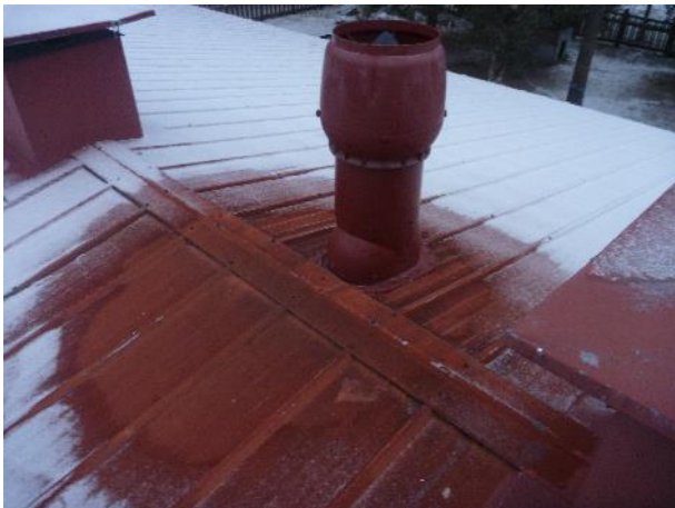
Kuva 31. Uusi ilmanvaihtohormi.
