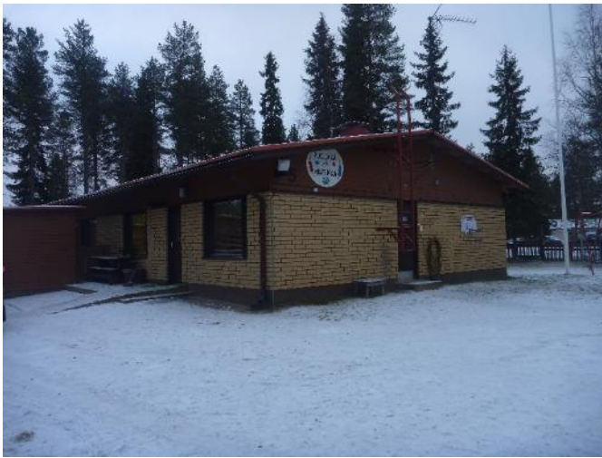
Kuva 3. Kuva rakennuksen etusivulta. Piha-alue on loivasti kallellaan rakennuksesta poispäin.
