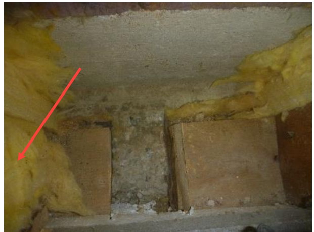
Kuva 15. RA1. Koolauksen villa on kiinni betonisokkelissa. Näyte M2 otettiin mineraalivillasta nuolen kohdalta.
