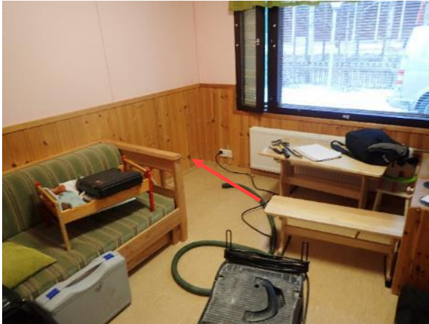
Kuva 6. Rakenneavaus RA1 tehtiin puolukan puolelle makuuhuoneen 1 pääty seinälle alapohjan ja ulkoseinän liittymään.
