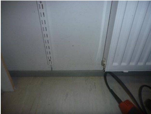
Kuva 26. Rakenneavaus RA3 tehtiin väliseinään käytävän ja siivouskomeron välille.
