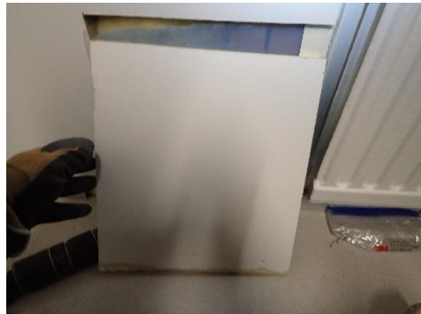
Kuva 27. RA2. Rakenneavauksen kohta sisällä. Sisäverhouslevy on uusittu.
