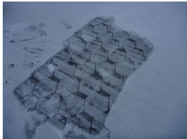
Kuva 48. Vesikatteen pinta tarkastettiin pistokoemaisesti. Kate on havaintojen mukaan hyväkuntoinen.
