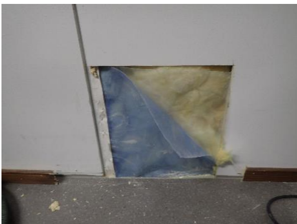
Kuva 40. Rakenenavauksen RA5 kohta eteisen ulkoseinässä.
