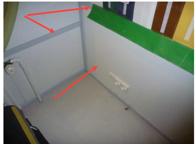
Kuva 17. RA1. Rakenneavauksen kohta sisällä. Seinien alaosan levytys ja höyrynsulkumuovi on uusittu listan kohdalle saakka.
