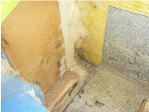
Kuva 24. RA1. Tuulensuojavilla on kiinni betonin pinnassa.
