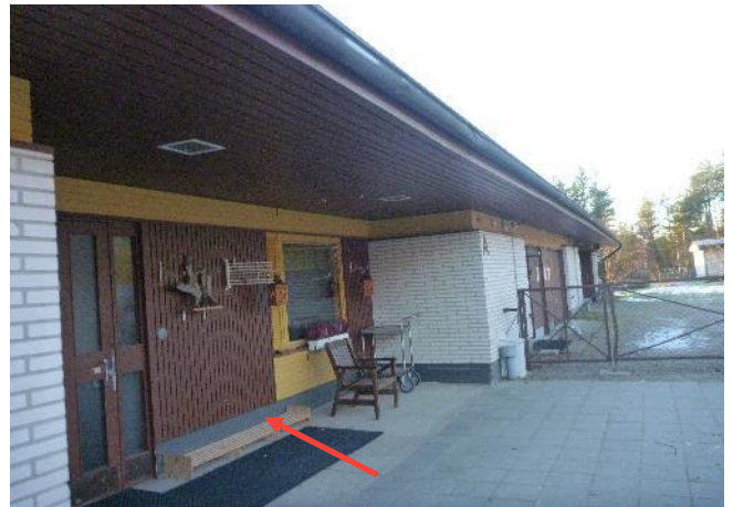
Kuva 39. Rakenenavauksen RA5 kohta ulkoa kuvattuna.
