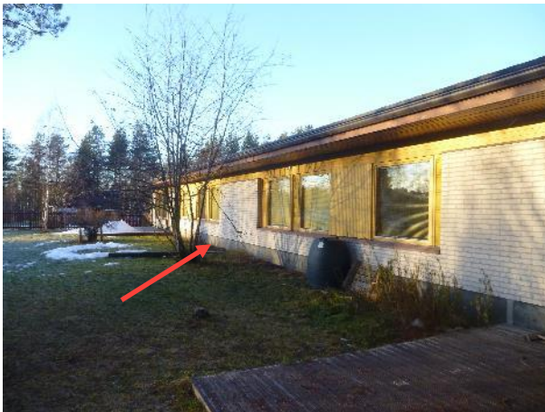
Kuva 26. Rakenneavauksen RA2 kohta ulkoa kuvattuna.
