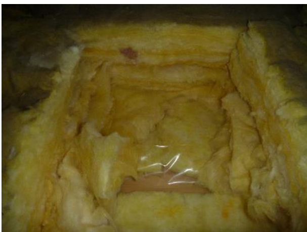
Kuva 53. Yläpohjaeristeenä on mineraalivillaa noin 250 mm.
