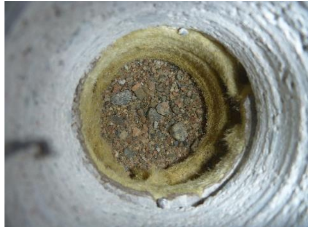
Kuva 13. RA6. Alapohjaeristeenä mineraalivilla.
