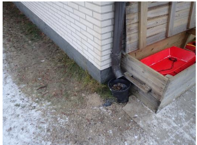
Kuva 6. Sadevedet on ohjattu sadevesikaivoihin.
