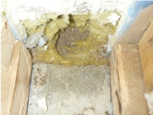
Kuva 9. RA1. Mineraalivillan alla maatayttönä on hiekka.
