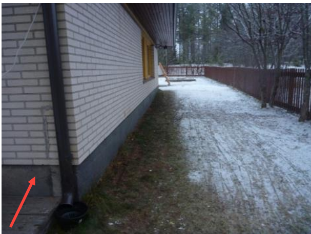
Kuva 34. Rakennauksen RA4 kohta ulkoseinien nurkassa. Maanpinta on tasainen.
