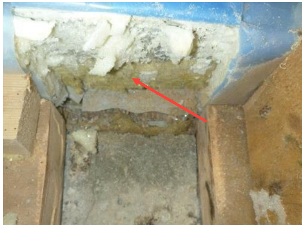
Kuva 8. RA1. Betonilaatan alla lämmöneristeenä on mineraalivillaa. Materiaalinäyte M2 otettiin nuolen kohdalta.
