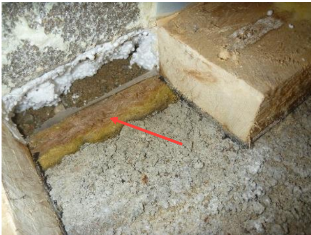
Kuva 38. RA4. Alapohjan lämmöneriste on vaihdettu. Sokkeliä vasten on alkuperäinen mineraalivilla.
