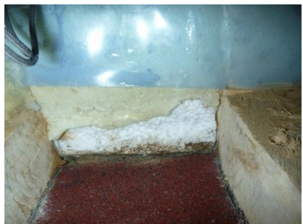
Kuva 15. RA4. Alapohjarakenne on uusittu. Mineraalivilla vaihdettu solumuovieristeeksi.
