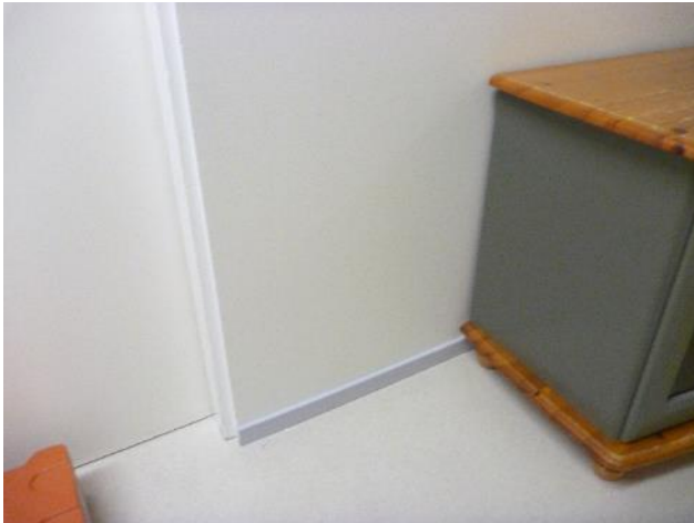
Kuva 43. Rakennusvaihe RA3 tehtiin väliseinän käytävän ja makuuhuoneen välille.
