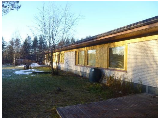
Kuva 4. Kuva rakennuksen takasivulta. Piha-alueen kallistus on tasainen.
