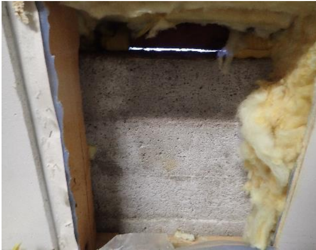
Kuva 42. RA5. Ulkoverhouksen ja sokkelin välissä ilmarako.
