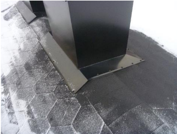
Kuva 49. Hormin pellitys on kiinnitetty katteen läpi kateruuveilla.
