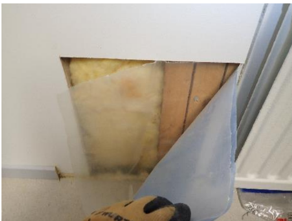
Kuva 28. RA2. Höyrinsulkumuovi lisätty korjauksessa.
