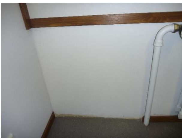
Kuva 14. Rakenneavaus RA4 tehtiin päiväkodin puolelle olohuoneen seinälle alapohjan ja ulkoseinän liittymään.
