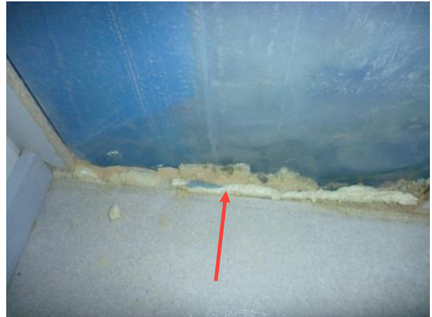
Kuva 19. RA1. Uuden höyrynsulkumuovin ja betonilaatan väli on tiivistetty uretaanivaahdolla.
