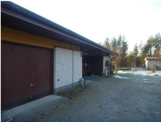
Kuva 3. Kuva rakennuksen etusivulta. Piha-alue on sorapintainen ja tasainen tai loivasti kallellaan rakennuksesta poispäin.
