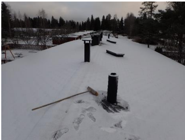
Kuva 47. Yleiskuva vesikatosta. Tarkastushetkellä katolla oli ohut lumikerros.
