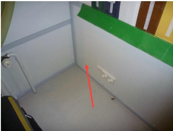
Kuva 7. Rakenneavaus RA1 tehtiin esikoulun puolelle olohuoneen pääty seinälle alapohjan ja ulkoseinän liittymään.
