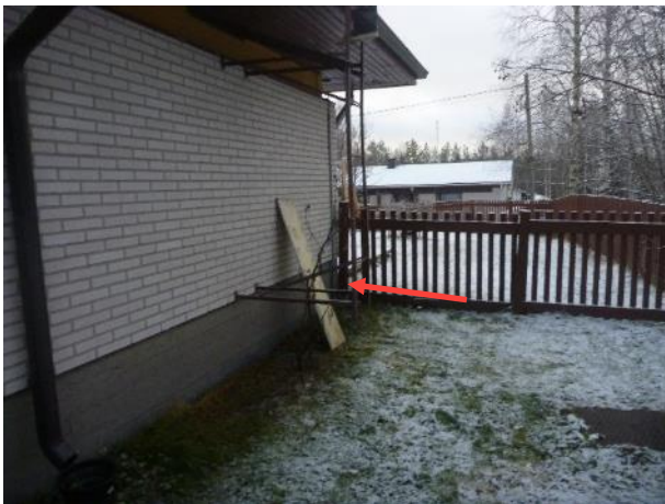
Kuva 16. Rakenneavauksen RA1 kohta ulkoa kuvattuna.
