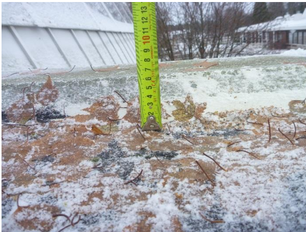
Kuva 40. Katon reunakorotus noin 60mm.
