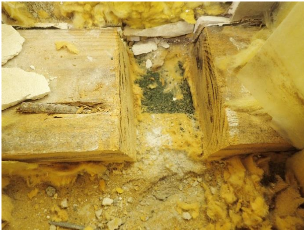
Kuva 20. Alaohjauspuun alla villakaistale ja bitumikermi.
