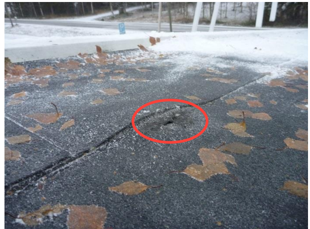
Kuva 41. Huopakatteessa pullistumia ja ympyrän kohdalla reikä.
