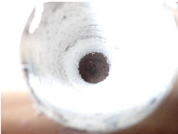
Kuva 12. Eristeen ja hiekan välissä noin 50mm painuma.
