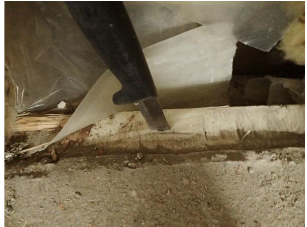
Kuva 31. RA5, autotallin alapohjalaattan valumuottina käytetty suulakepuristettua polystyreeni-levyä.
