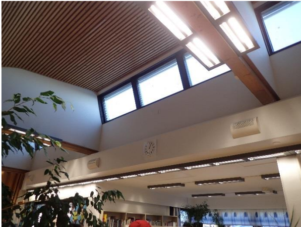
Kuva 38. Sisäänpäin kallistuvat kattoikkunat sisältäpäin.
