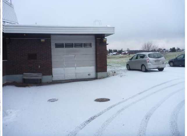
Kuva 4. Autotallin kohdalla kallistus rakennukseen päin, sadevesikaivo oven edustalla.
