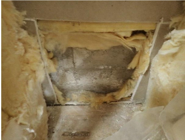
Kuva 18. Kipsilevyn ja sokkelin välissä villaa.
