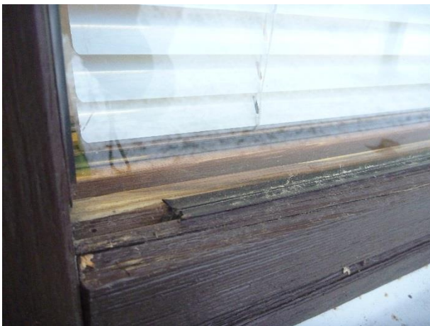
Kuva 34. Kolmelasiset MSK-ikkunat, karmissa lievää maalihilseilyä.
