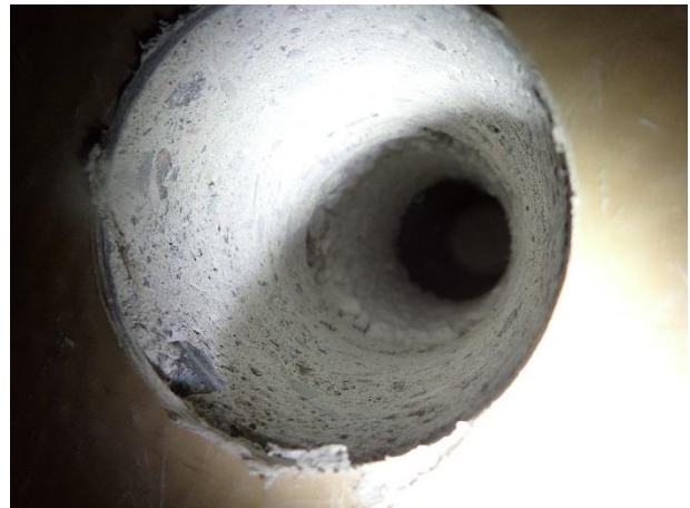
Kuva 11. Betonilaatta 85mm, eriste 100mm.
