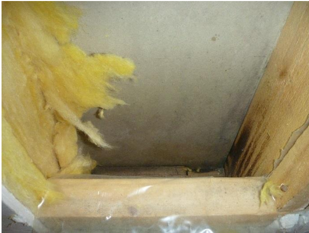
Kuva 24. RA4, Pohjoispuolen ulkoseinä.
