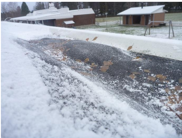
Kuva 42. Pullistuma huopakatteessa.
