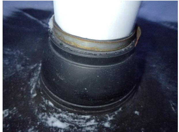
Kuva 25. Läpivientikaulukset ovat kunnossa.
