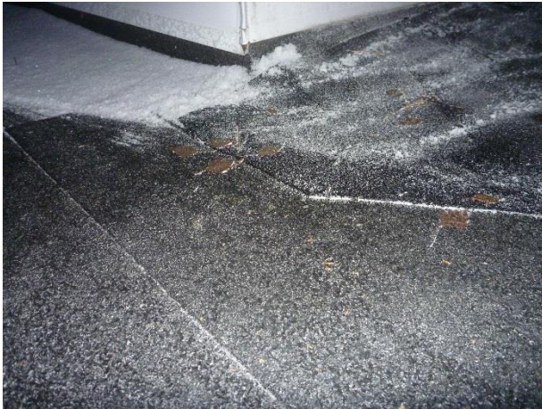
Kuva 24. Vesikate on hyväkuntoinen.
