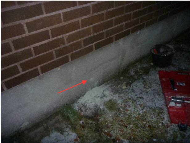
Kuva 13. Itäpäädyän ulkoseinän rakenneavauksen kohta merkattu nuolella.
