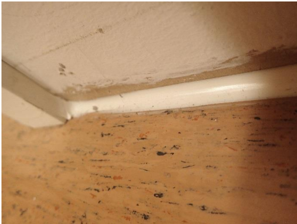
Kuva 18. Tiivistysmassaa toimistohuoneen väliseinän ja lattian liitoksessa.
