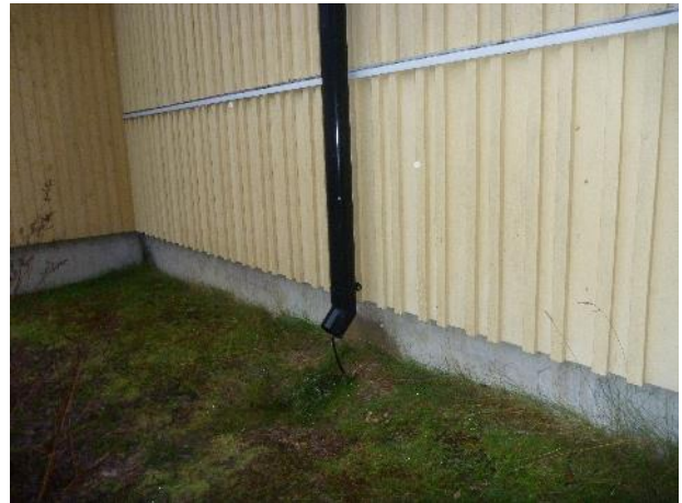
Kuva 89. Alapohjarakenne tarkastettiin ulkoseinäavauksen kohdalta. RA15
