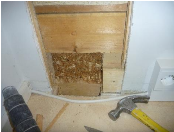
Kuva 44. RA7. Umpilaudoituksen takana puukuitulevy ja eristeenä sahapuru.
