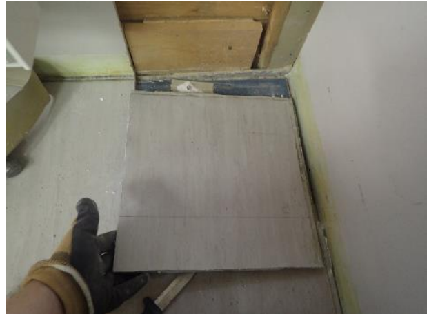
Kuva 10. RA1. Pällimmäisenä lattiakerroksena on muovimatto ja kipsilevy.
