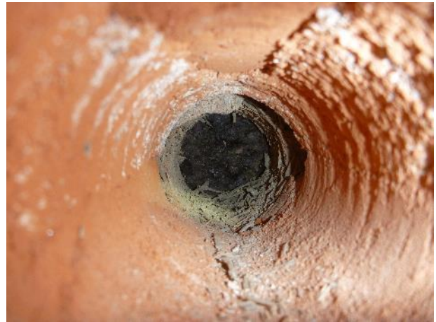
Kuva 49. RA10. Tiiliverhouksen ja runkobetonin välissä tojax eriste ja bitumisively. Näyte M6 toja-eristeestä.
