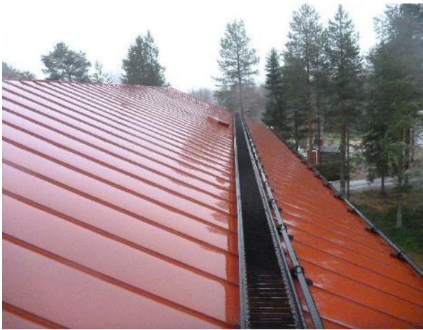
Kuva 95. Yleiskuva laajennuksen vesikatteesta. Katolla on kulkusillat ja lumiesteet.
