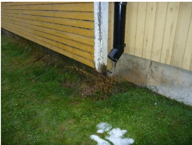
Kuva 6. Sadevedet on ohjattu rakennuksen vierelle. Vesi kastelee rakennuksen seinärakennetta.
