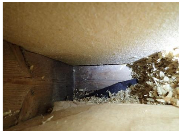
Kuva 41. RA2. Entinen ulkoseinäeriste on poistettu. Kuvan eriste on alapohjaeristettä.
