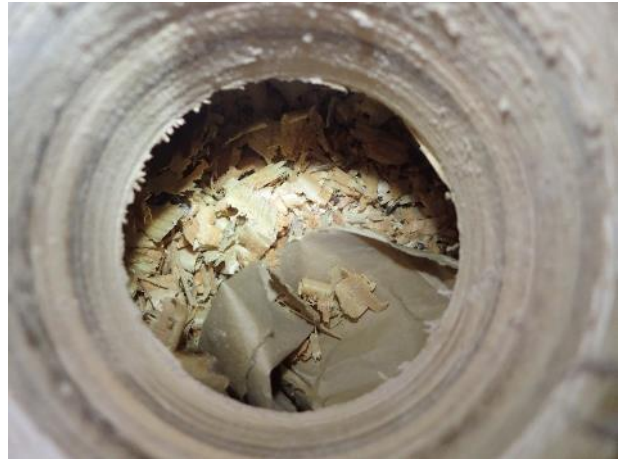
Kuva 18. RA5. Lämmöneristeessä ei havaittu näkyviä vaurioita eikä poikkeavaa hajua.
