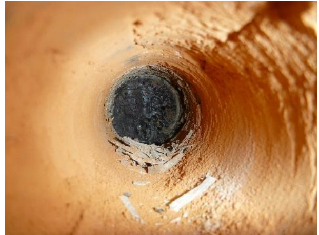
Kuva 51. RA12. Tiiliverhouksen ja runkobetonin välissä tojox eriste ja bitumisively. Näyte M7 tojox eristeestä.
