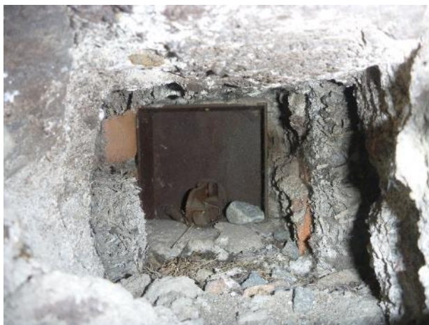
Kuva 27. Tuuletusaukot olivat kiinni tutkimushetkellä.
