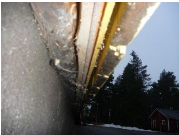
Kuva 60. Vanhan osan ulkoveriverhousen tausta ei tuuletu.
