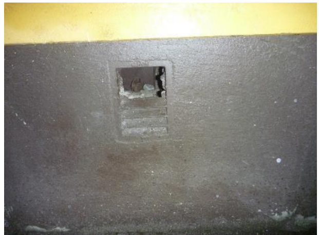
Kuva 26. Rakennuksen sokkelissa on kaksi kappaletta tuuletusaukko ryömintätilaan.
