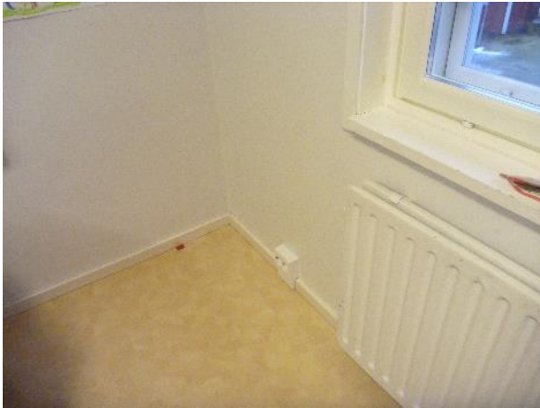
Kuva 65. 2. kerroksen välipohjan rakenneavaus RA7 tehtiin ulkoseinän liittymään.
