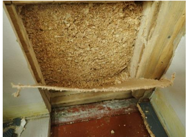
Kuva 37. RA1. Ulkoseinäeristeenä sahanpuru. Rakenneavauksessa ei havaittu poikkeavaa hajua.
