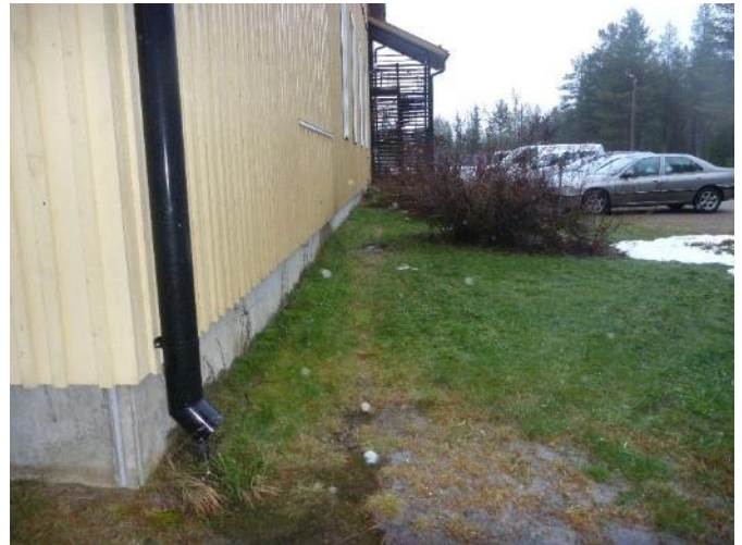
Kuva 87. Sadevedet on ohjattu rakennuksen vierelle.
