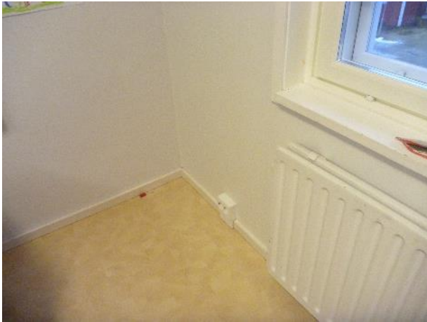
Kuva 42. Rakenneavaus RA7 tehtiin ulkoseinän ja välipohjan liittymään, tila 210.
