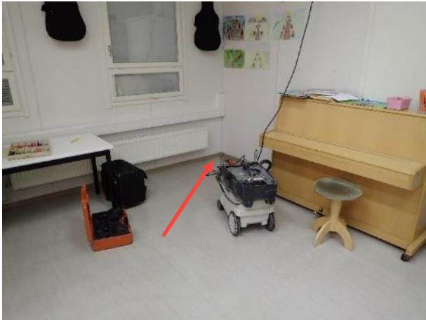
Kuva 9. Rakenneavaus RA1 tehtiin luokkatilan 118 alapohjan ja ulkoseinän liittymään.
