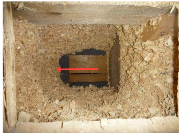
Kuva 20. RA6. Kutterinpurueristeen alla on tulensuojapaperi. Ryömintätila ja alapuoliset rakenteet kuvattiin tämän avauksen kautta. Näyte M10 otettiin nuolen kohdalta.
