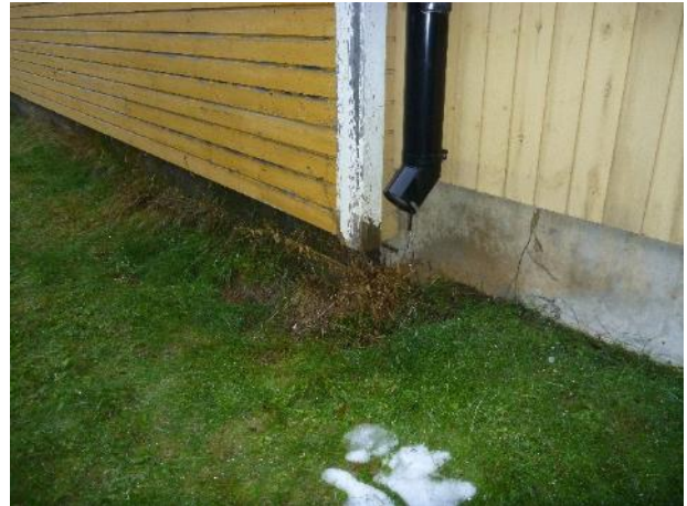
Kuva 53. RA13. Rakenneavauksen kohdalla syöksyputki.
