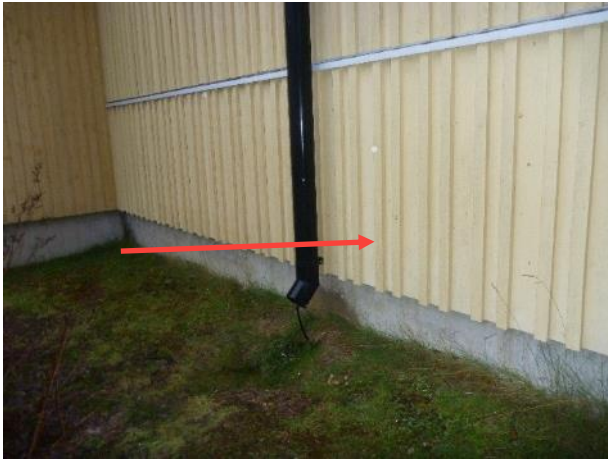
Kuva 91. Rakenneavauksen RA15 kohta liikuntasalin kohdalla.
