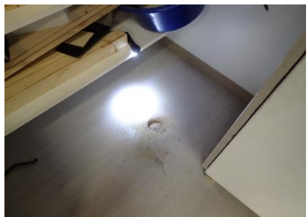
Kuva 16. Rakenneavaus RA5 teknisentyöluokan lattiaan putkikanaalin yläpuolelle.
