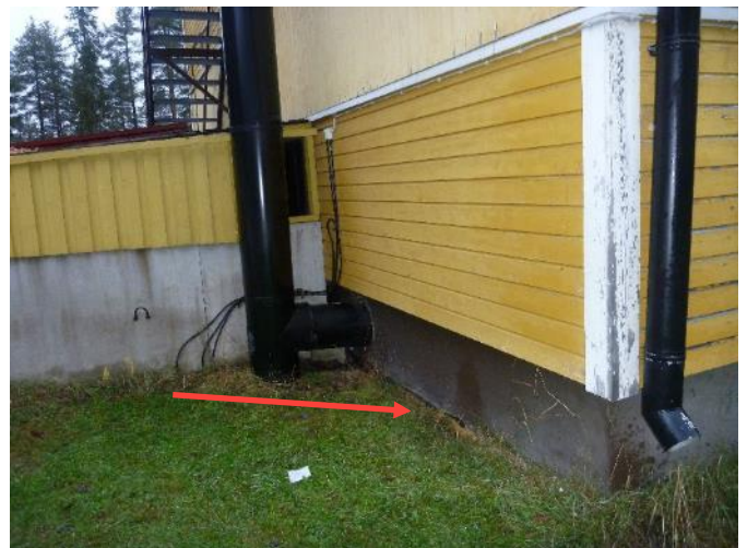
Kuva 7. Hakepoltinhuoneen kohdalla on paikallisesti asennettu patolevy.
