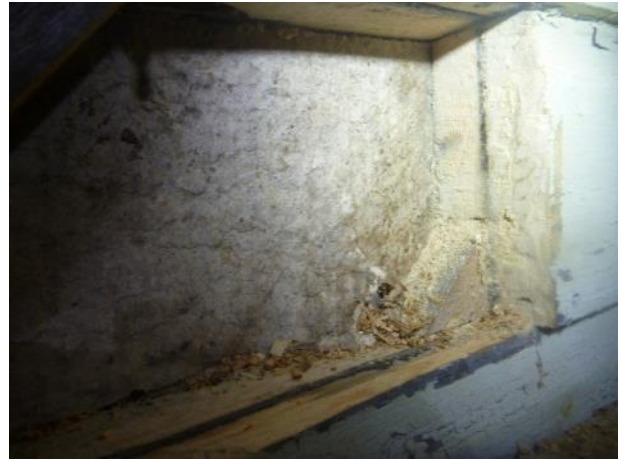
Kuva 57. RA14. Ulkoveriverhousen takana umpilaudoitus, kartonki ja ulkoseinärunko.
