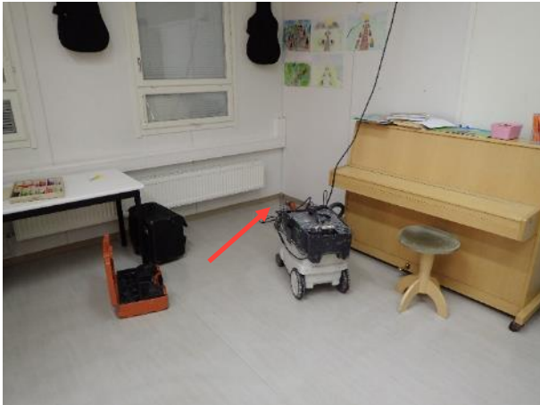
Kuva 34. Rakenneavaus RA1. Tehtiin ulkoseinän ja alapohjan liittymään.
