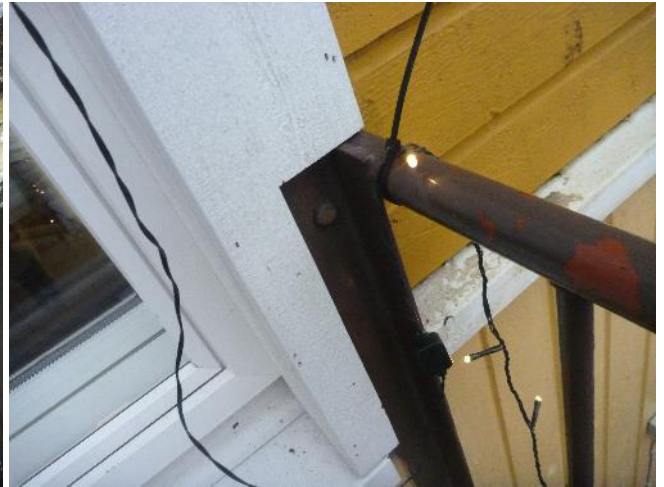
Kuva 83. Parveke on kiinnitetty seinärunkoon kansiruuveilla.
