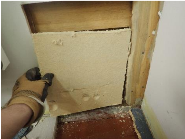
Kuva 36. RA1. Umpilaudoituksen takana on puukuitulevy. Levyn pinnalla ei havaittu vaurion merkkejä.
