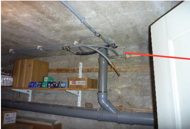
Kuva 63. Läpivienti kellarista välipohjan läpi 1. kerrokseen.
