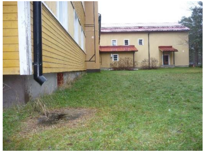
Kuva 5. Kuva rakennuksen takasivulta. Piha-alueen kallistus on loiva ja paikoin tasainen. Rakennuksen vierustat ovat nurmipintaiset.
