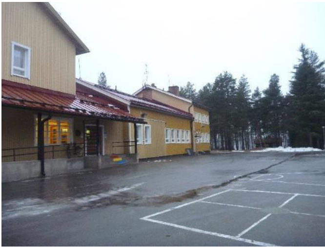
Kuva 4. Kuva rakennuksen etusivulta. Piha-alue on asfalttipintainen ja kallistus on loiva rakennuksesta poispäin.
