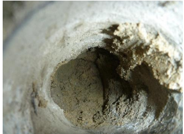
Kuva 32. RA11. Betonilaatan alla täyttömaa on märkää.
