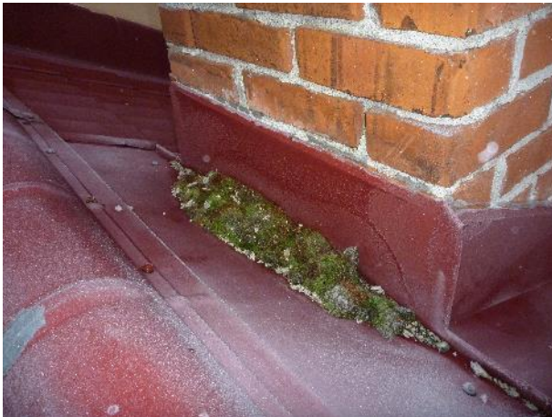
Kuva 69. Hormin juurella on sammalta. Kerääntyvä vesi vähentää pellin käyttöikää.
