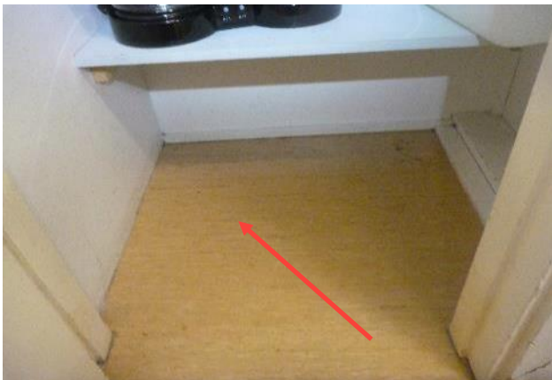
Kuva 61. 1. kerroksen välipohjan rakenneavaus RA4 tehtiin keittiön 131 komeroon.
