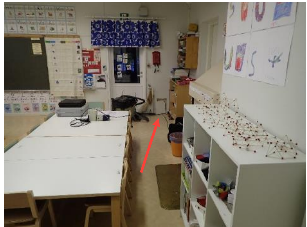
Kuva 45. Rakenneavaus RA8 tehtiin 2. kerroksen tilaan 211, rakennuksen päätyseinälle.
