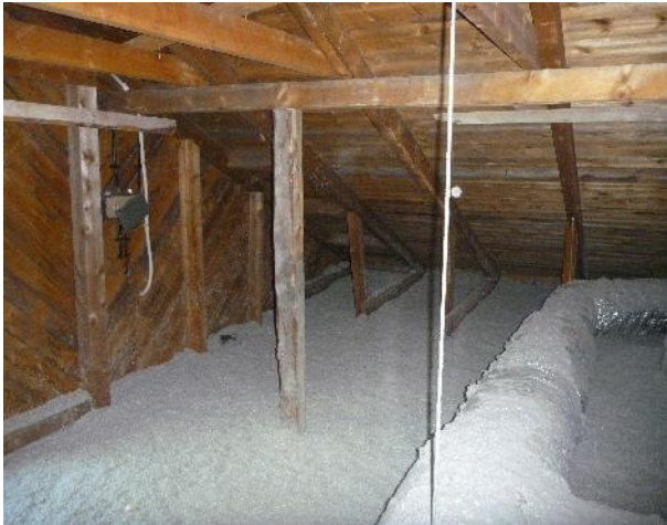
Kuva 73. Yleiskuva vanhan osan yläpohjasta.
