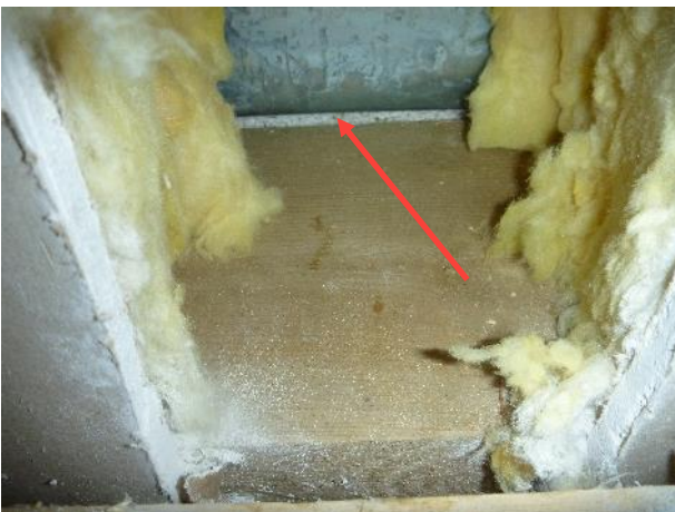
Kuva 90. Alapohjaeristeenä styrox eriste.
