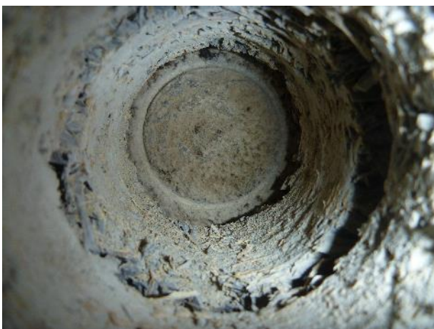
Kuva 54. RA13. Rakenneavauksessa tunkkainen haju. Näyte M11 tojox eristeestä.
