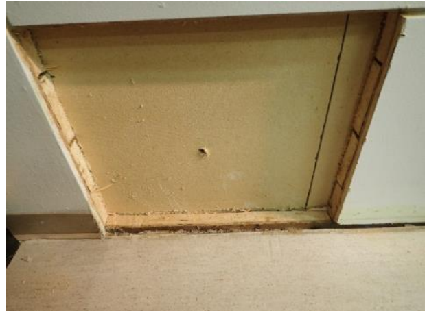
Kuva 39. RA2. Alkuperäinen umpilaudoitus ja puukuitulevy on paikoillaan.
