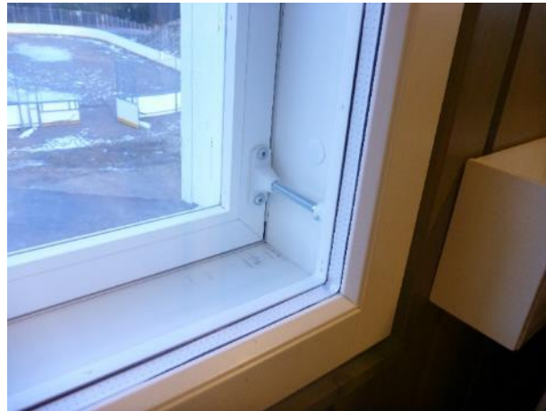
Kuva 94. Kuva laajennuksen ikkunasta. Ikkunat ovat hyväkuntoiset.
