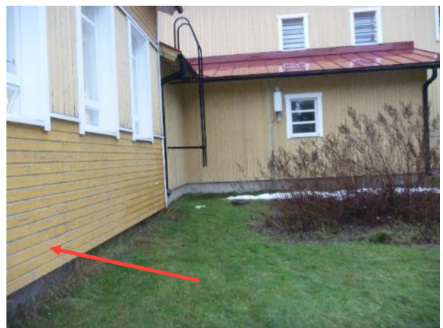
Kuva 55. Rakenneavaus RA14 tehtiin luokkatilan 118 kohdalle.
