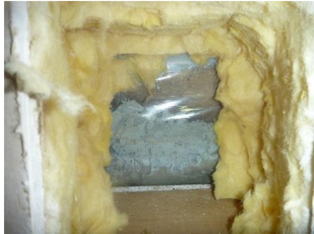
Kuva 92. RA15. Mineraalivillassa ei havaittu vaurioita.
