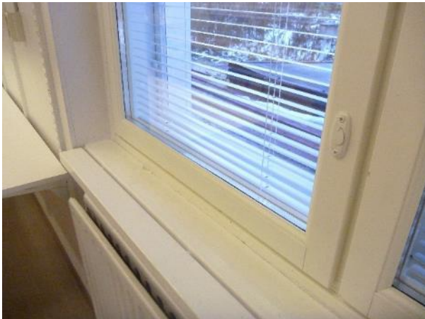
Kuva 58. Kuva vanhan osan ikkunasta. Ikkunat ovat uusittu. Ikkunat ovat hyväkuntoiset.
