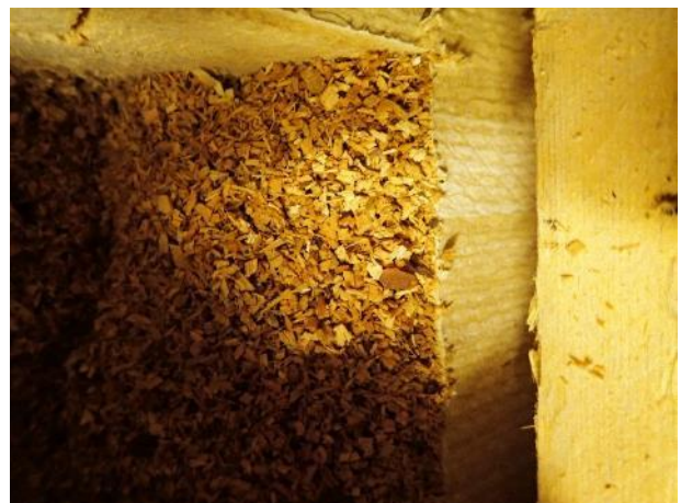
Kuva 47. RA8. Ulkoseinäeristeessä ei havaittu merkkejä vaurioista.
