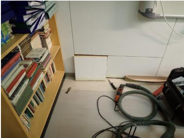
Kuva 38. Rakenneavauksen RA2 kohta, vanhan osan päätyseinä laajennusta vasten. Nykyinen väliseinä.
