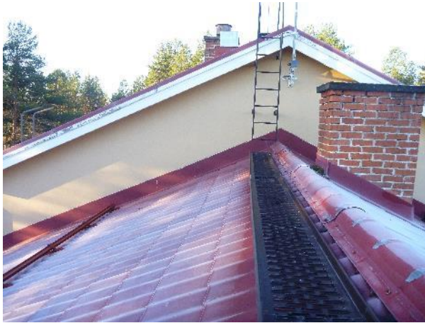
Kuva 67. Yleiskuva vanhan osan vesikatteesta. Katolla on kulkusillat ja lumiesteet.
