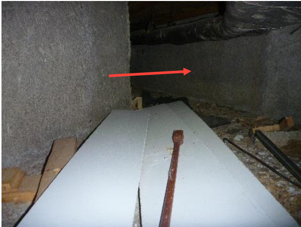
Kuva 52. Rakenneavaus RA13 putkikanaalin ulkoseinässä.
