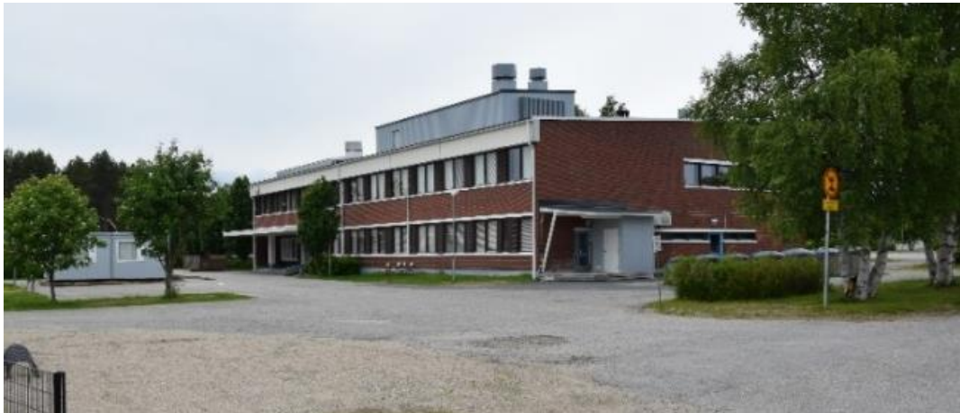
Ranuan kirkonkylän vanha yläkoulu. Koulu asetettiin käyttökieltoon sisäilmaongelmien vuoksi. Vanhan koulun tilalle tuli vuonna 2016 rakentaa pikaisella aikataululla uusi koulu. Uusi koulu toteutettiin Aapiskujan koulukeskukseen vanhan alakoulun taakse. Vanha, vuonna 1955 valmistunut Pappilantien varressa sijaitseva koulurakennus on tarkoitus purkaa, jolloin sen alue vapautuu muuhun käyttöön.
