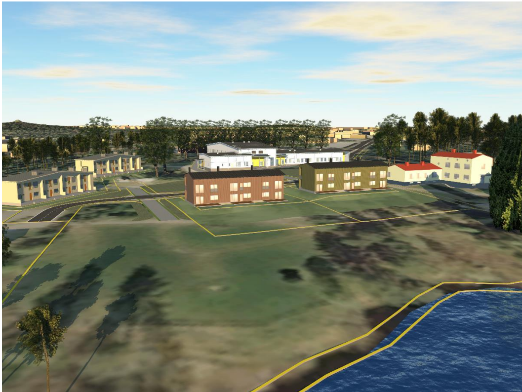
Kuva 10. Näkymä Ranuansalmelta. Uusien asuinrakennusten ja Ranuansalmen väliin jätettiin viheraluekaista. Taustalla uusi sairaala ja oikealla vanha. Uuden sairaalan edestä purettiin entinen sairaalarakennus talvella 2019.
