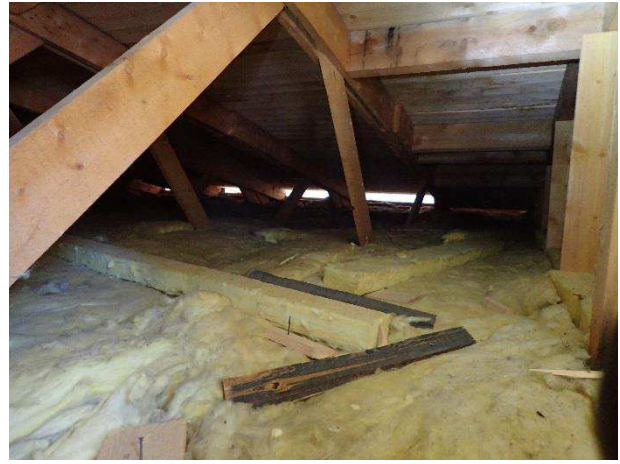
Kuva 37. Yläpohja tuulettuu räystäiden kautta.
