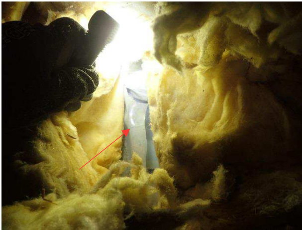
Kuva 38. Lämmöneristeiden alla höyrnsulkumuovi.
