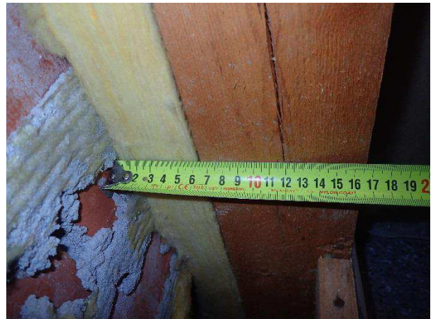
Kuva 29. RA2, Lämmöneristysvahvuus yhteensä 150 mm, josta runko 100 mm.
