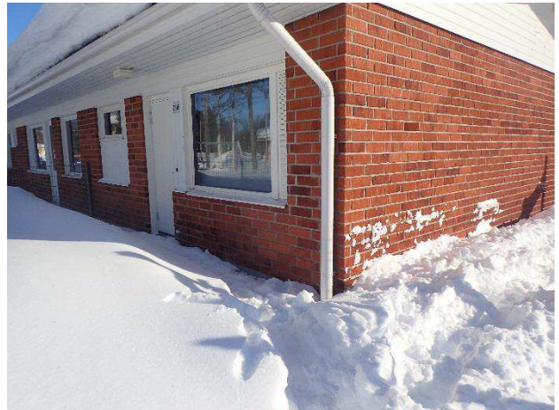
Kuva 8. Kuva rakennuksen takapäädystä. Maanpinta on korkeammalla etupäätyn verrattuna.
