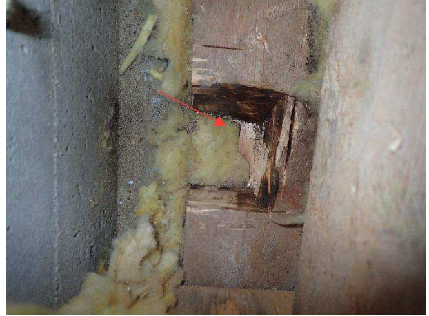
Kuva 33. RA4, Mikrobinäyte M5 alaohjauspuun alapinnasta.
