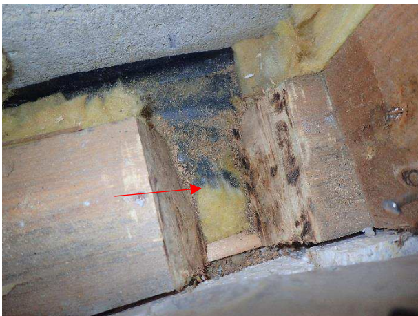
Kuva 30. RA3, Mikrobinäyte M4 villakaistaleesta alaohjauspuun alta.
