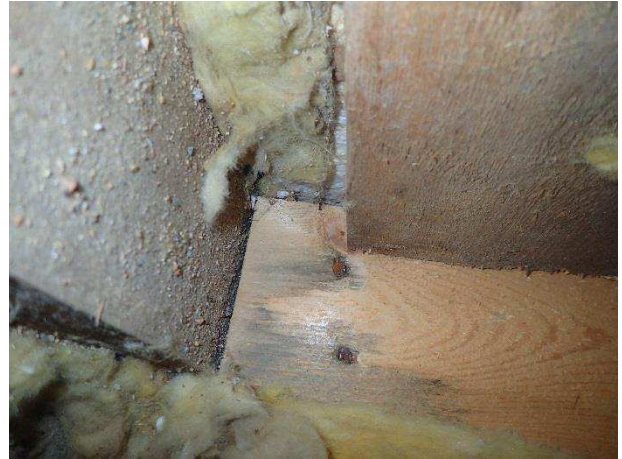
Kuva 35. RA4, Alaohjauspuussa kosteuden aiheuttamaa tummentumaa.
