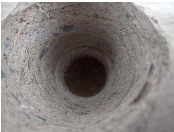
Kuva 16. RA5, Alapohjalaatta noin 80 mm, lämmöneriste 50 mm.
