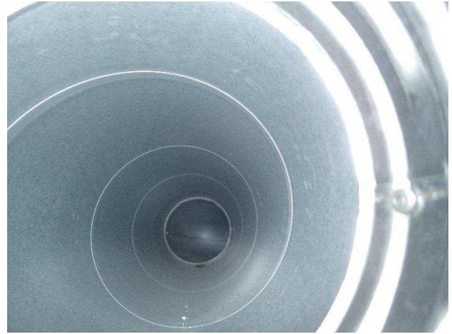
Kuva 2. Pääosin tuloilmakanavat ovat puhtaat.
