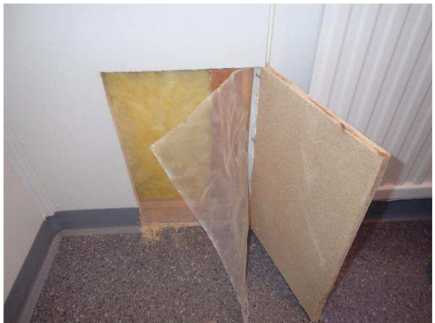
Kuva 25. RA2 Höyrynsulkumuovi lastulevyn takana.
