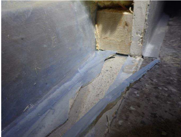
Kuva 20. RA1, Ulkoseinää on lisäeristetty rakenteen sisäpuolelta 50 mm koolauksella.
