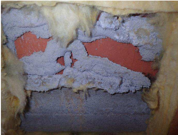
Kuva 22. RA1, Sokkelin yläreuna alapohjalaatan yläreunan tasalla.
