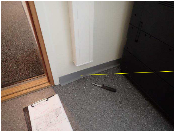
Kuva 14. Alapohjan ja kantavan väliseinän liitos tarkastettiin listan takaa.
