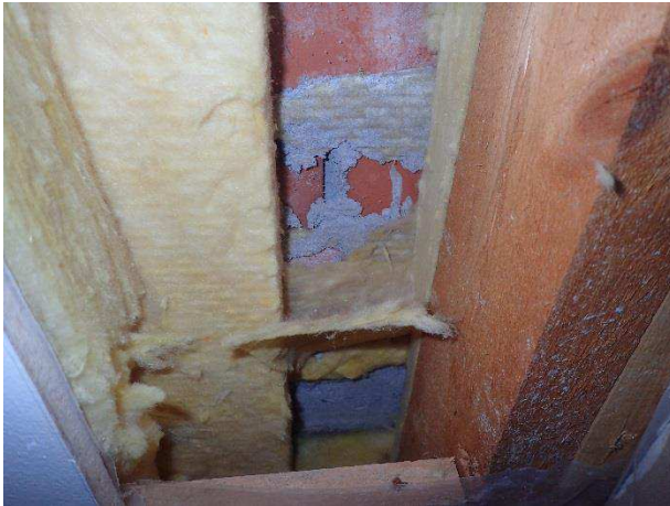
Kuva 26. RA2, Lämmöneristys kiinni suoraan tiiliverhoilussa.
