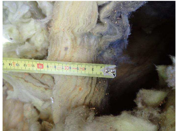
Kuva 39. Yläpohjan eristevahvuus noin 200 mm.
