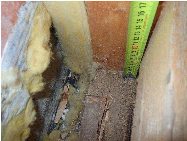
Kuva 28. Alaohjauspuun yläpinta ~ 180 mm alapohjalaatan yläpinnasta
