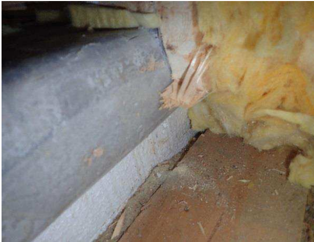
Kuva 12. RA1, Seinän höyrynsulkumuovi käännetty alapohjalaatan alle.
