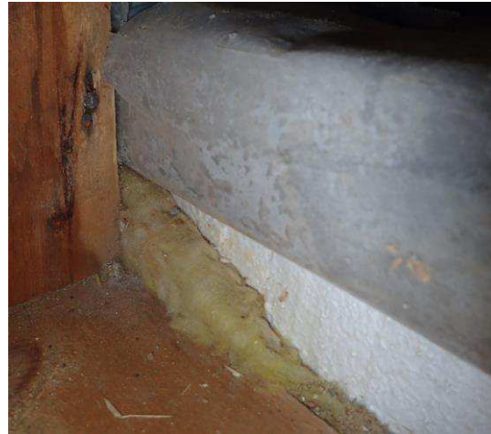
Kuva 13. RA1, Alapohjalaatan reuna päättyy ulkoseinän runkotolppaan.
