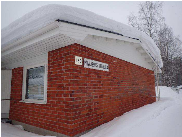
Kuva 7. Kuva rakennuksen etupäädystä.
