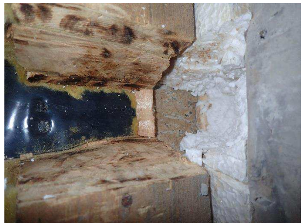
Kuva 31. RA3, Alaohjauspuun alla villakasitale ja kapillaarikatkona kermi.
