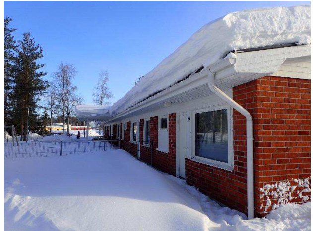
Kuva 6. Kuva rakennuksen takasivulta. Maanpinta on korkeammalla etupihaan verrattuna.
