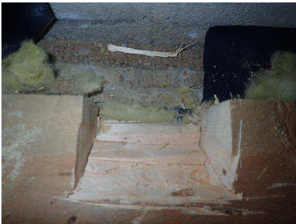
Kuva 24. RA1, Alaohjauspuun alla villakaistale ja bitumikermi.
