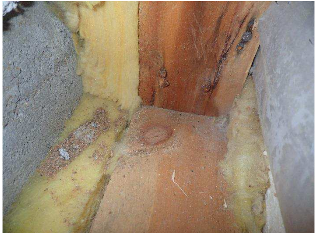
Kuva 23. RA1, AOP:n ja alapohjaeristeen välissä villatilke.
